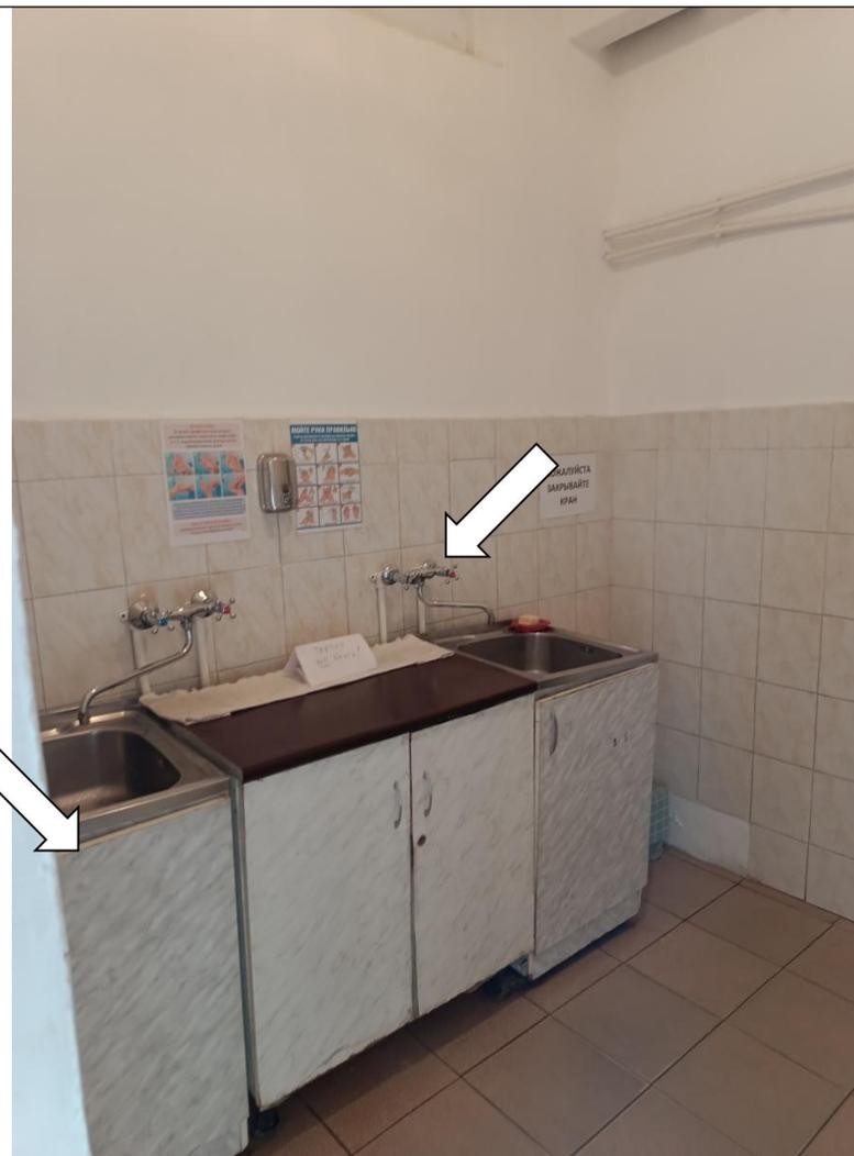
Фото № 14. Установлены краны поворотного типа, нет опорного поручня возле умывальника.
